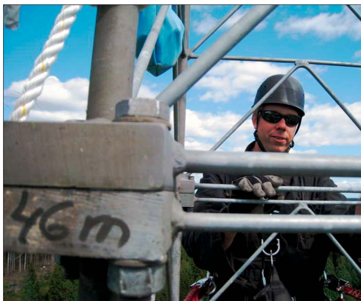
Det är inte ovanligt att se Gunnar SM3SGP långt uppe i någon av de masterna som finns på SK3W. Här är det påbyggnad av USA-masten som gäller, under sommaren växte masten från 30 meter till 68 meter. Foto: SM5PHU.
