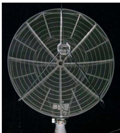
6m-parabolen på Kvarnberget bestyckad med dipol BFR-matare för NAC.
