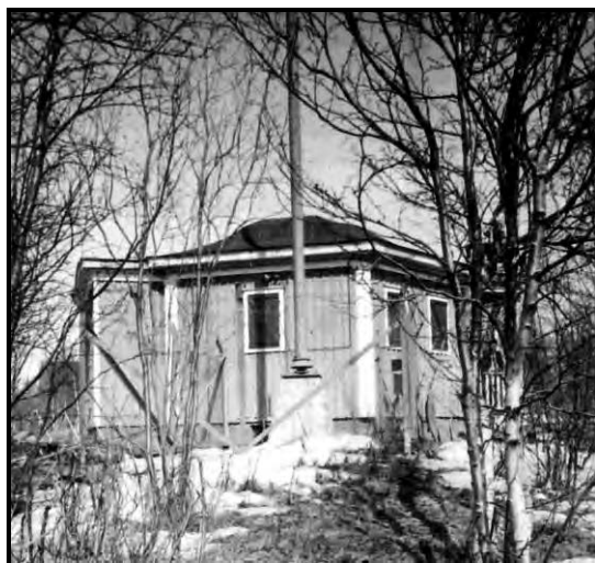
Stationshus och mastfundament från väster.
