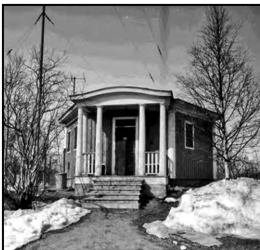
Stationens entré från öster.
