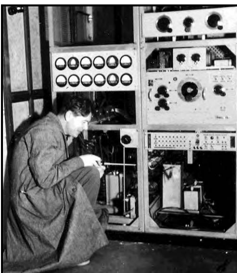
Förste reparatör Karl-Erik Stenberg från Luleå ansvarade för monteringen av den nya ordinarie sändaren för P1. Monteringen påbörjades i slutet av 1951. Sändaren var av fabrikat SATT, typ KSMS 500 och hade 500w avgiven effekt.
